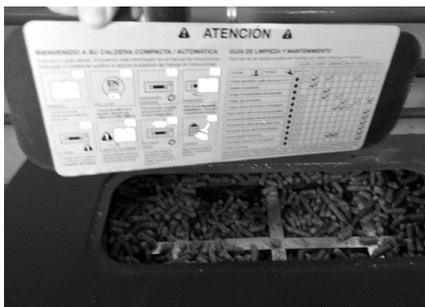
Figura 47 - Etiqueta com as tarefas de manutenção
